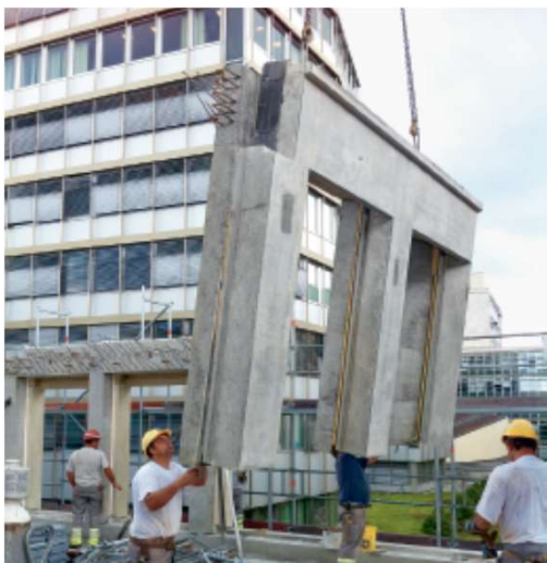
Pose d'une façade préfabriquée
