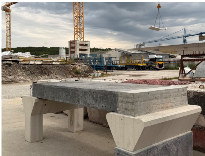
Remploi de dalles sciées sur chantier
